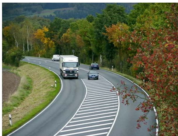
Beispiel: B 27 – Bebra Höhe Kläranlage
