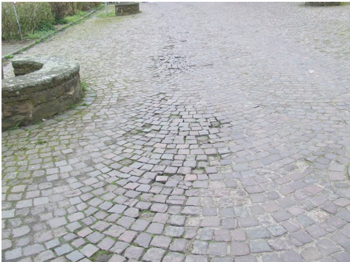
Kanaldeckel stehen hoch und darum befinden sich deutliche Vertiefungen und Verdrängungen.
